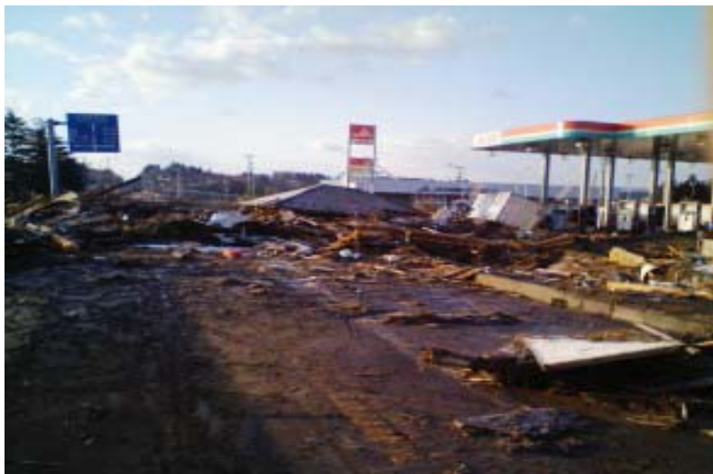
【写真① 国道6号】 津波による瓦礫(山元町坂元地内) 仙台方面から福島県境方面(南方向)を撮影
