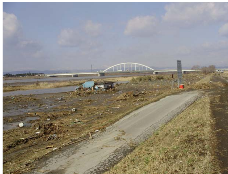
写真⑧ 現地状況(川側) (河口から左岸1.9k付近 若林区日辺地先)
