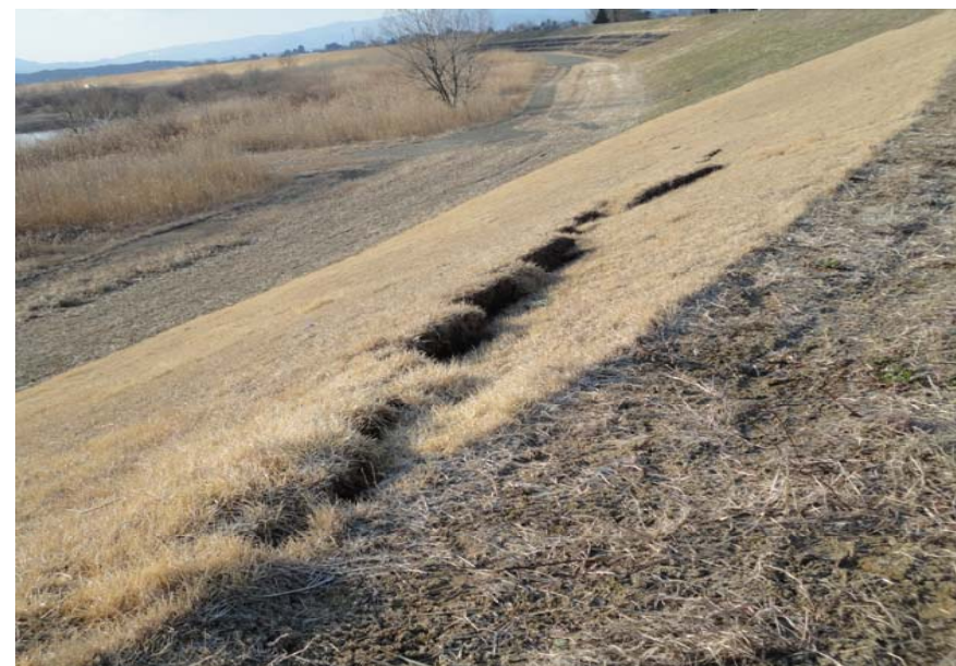
写真④ 堤防法面崩壊 (河口から左岸21.0k付近 角田市江尻地先)
