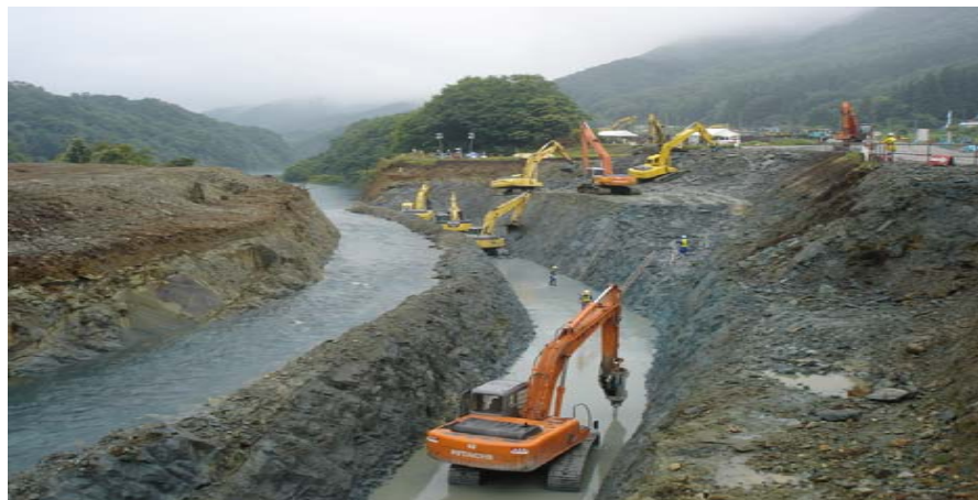
断面拡幅掘削をしながら、仮排水路を流下する磐井川
