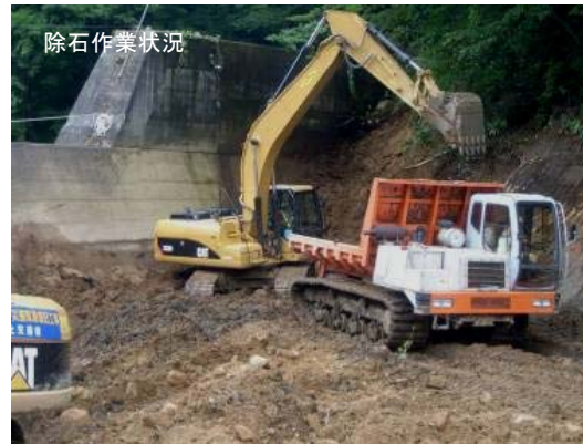
除石作業状況
