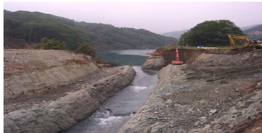
完成した断面拡幅部を流下する磐井川
