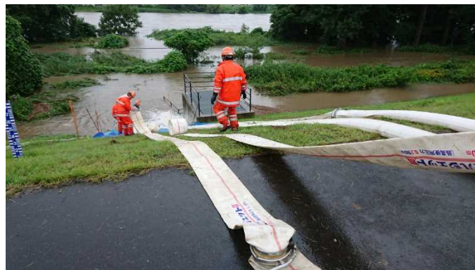
排水作業の事例
