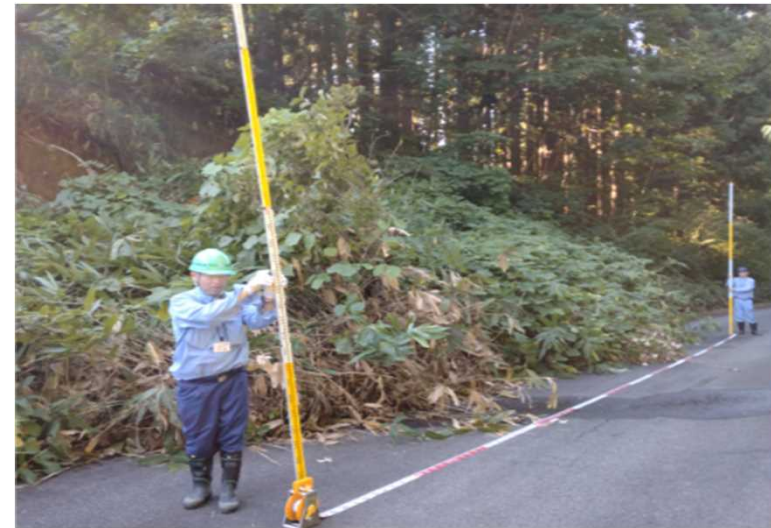
先遣調査班⑥一1 被災状況調査(山形県舟形町)
