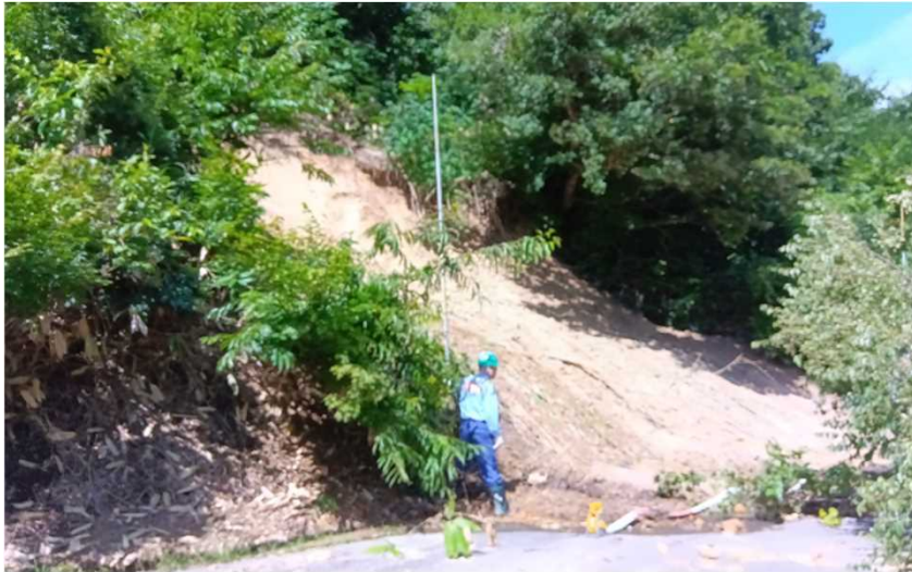
先遣調査班⑥一1 被災状況調査(山形県舟形町)
