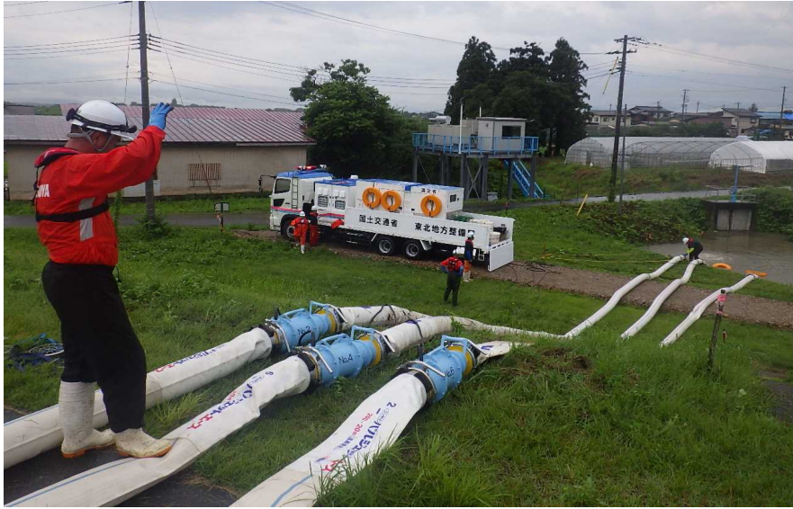
▼排水ポンプ車稼働状況（最上川 河北町谷地内）
