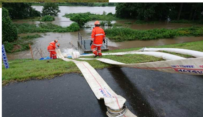
排水作業の事例
