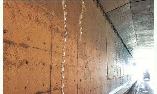
ひび割れ注入工法による補修 ※写真は施工中
