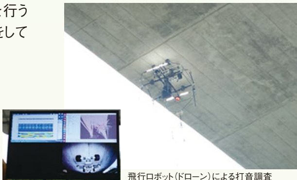
飛行ロボット(ドローン)による打音調査
