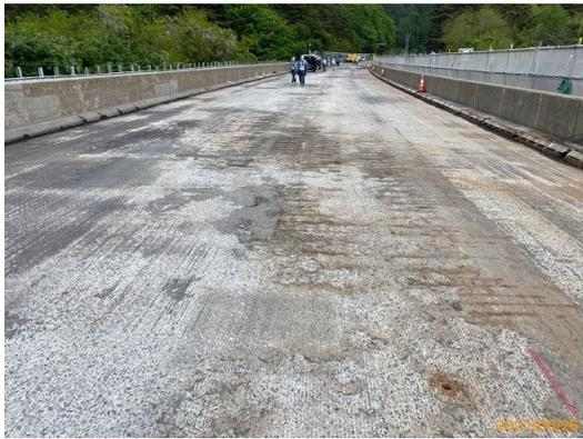
写真4-14 【損傷】床版の剥離・鉄筋露出
