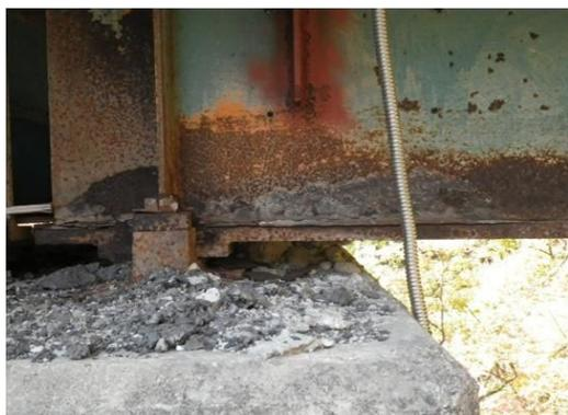
写真4-22 主桁端部の腐食
