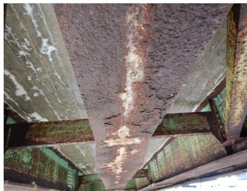
写真4-23 主桁の全般的な腐食
