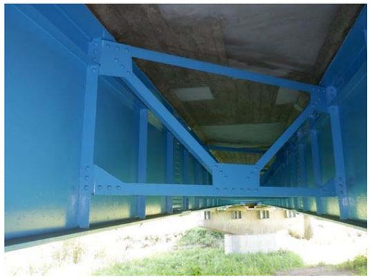
写真4-9 【対策】主桁：再塗装
