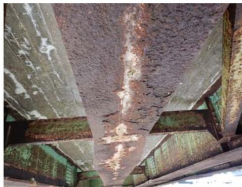
写真4-23 主桁の全般的な腐食
