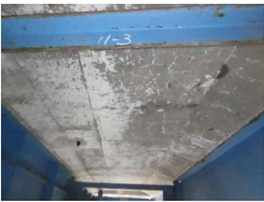
写真4-11 【損傷】床版ひびわれ
