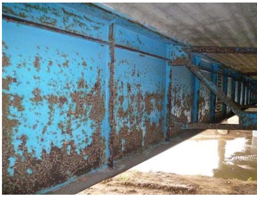
写真4-8 【損傷】主桁：腐食
