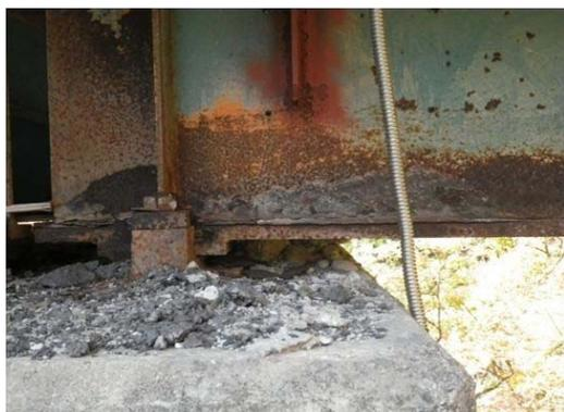
写真4-22 主桁端部の腐食
