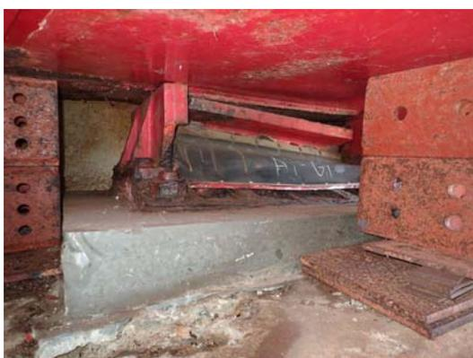
写真4-2 【損傷】支承のゆるみ・脱落
