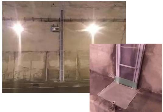
写真4-18 【対策】導水樋設置
