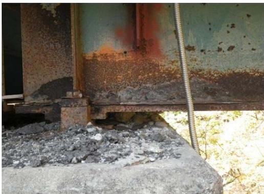
写真3-3 主桁桁端部の腐食
