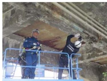
写真5-6 桁の近接目視状況
