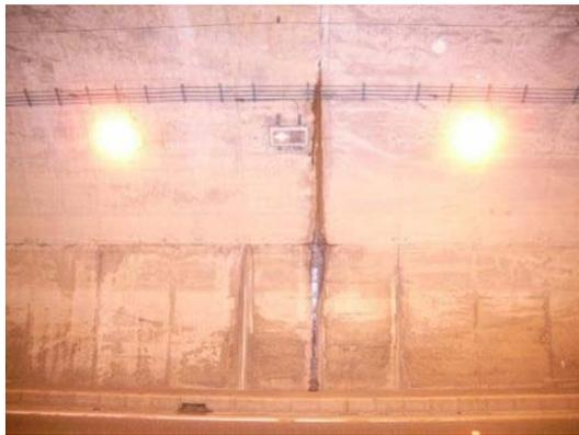
写真4-17 【損傷】壁面からの漏水
