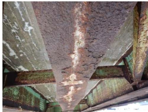
写真3-4 主桁の全般的な腐食
