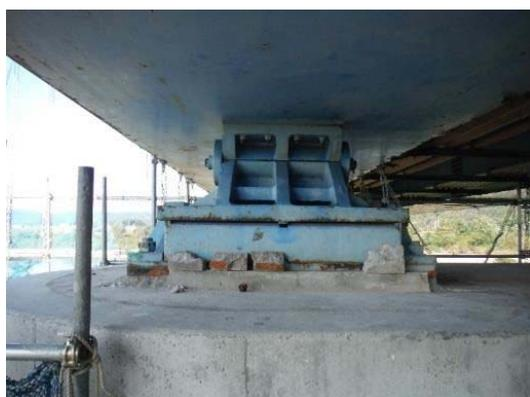
写真4-8 【損傷】支承：防食機能の劣化
