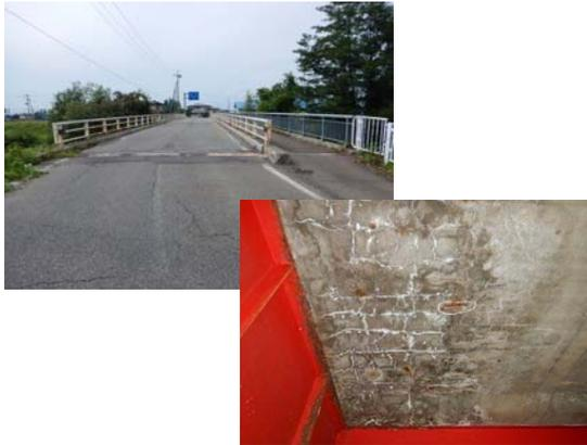
写真4-11 【損傷】床版：ひびわれ（格子状）
