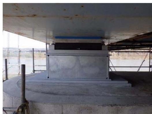
写真4-9 【対策】支承交換（耐震補強含む）
