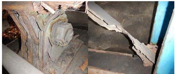
写真4-19 【損傷】腐食
