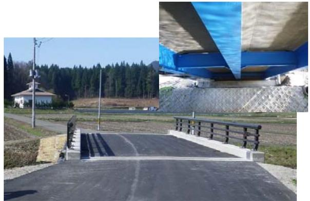
写真4-12 【対策】床版打替、防水工
