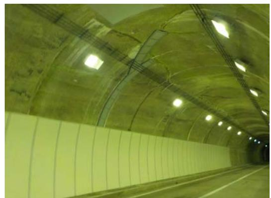
写真4-21 【対策】線導水・面導水
