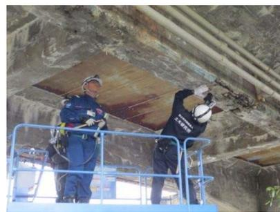
写真5-6 桁の近接目視状況
