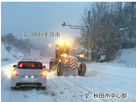
写真1 国道7号秋田南バイパス大雪時の除雪状況
