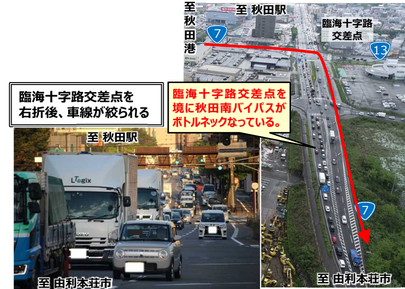
写真3・4 臨海十字路交差点西側の状況
