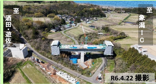
③ 川袋小川橋上部工工事
