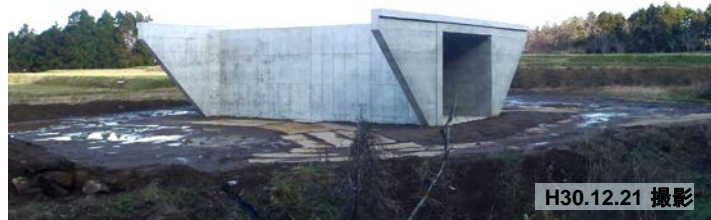
④ 栗目木沢橋下部工工事
