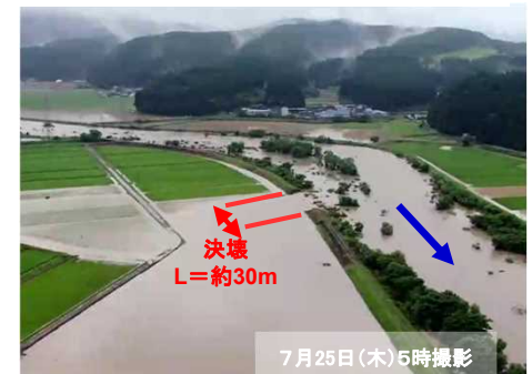
石沢川 右岸約4.0k付近
