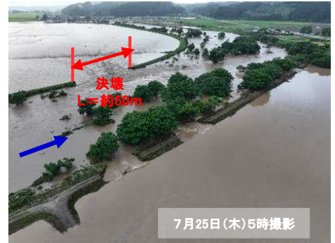
石沢川 右岸約3.5k付近
