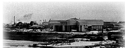
旧雄物川から見た茨島の工場群(昭和40年)
