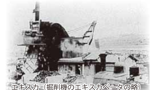
エキスカ(掘削機のエキスカベータの略)
