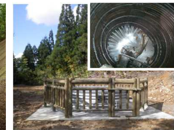
地すべり防止工
