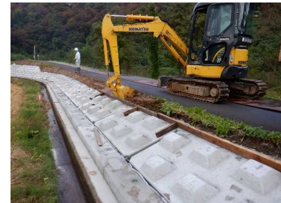
▲堤防裏法尻補強状況
