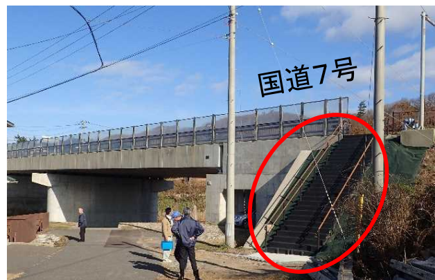
①避難路(階段)R3.3月完成
