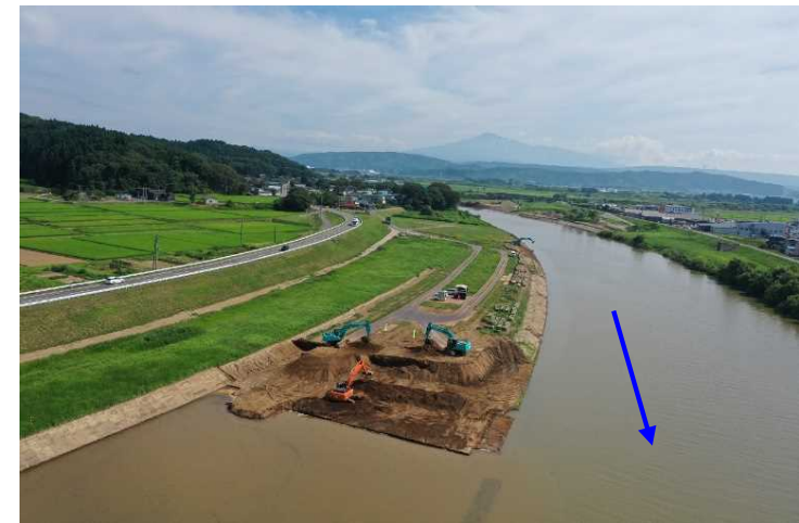
▲河道掘削状況
