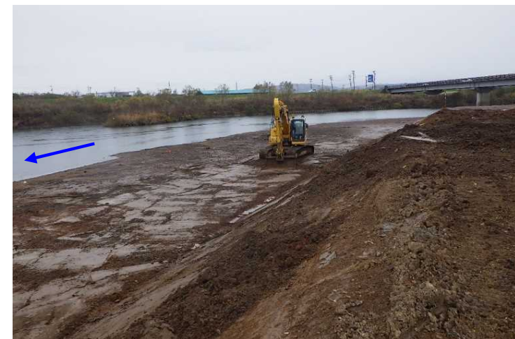
▲河道掘削状況
