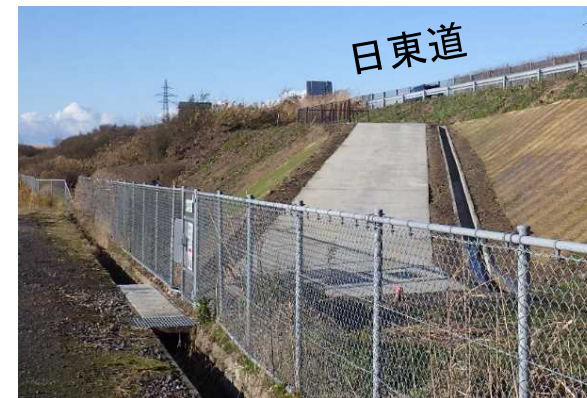
③避難路(スロープ)R3.12月完成
