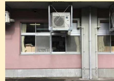
エアコン室外機を吊り下げ設置
