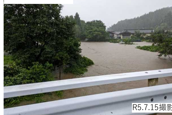
新城川浸水状況
