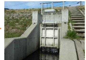
整備後 (フラップゲート設置)
