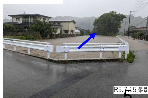
新城川浸水状況
