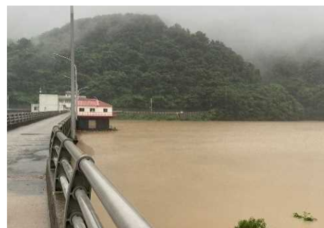
岩見川柳町水位観測局水位状況
