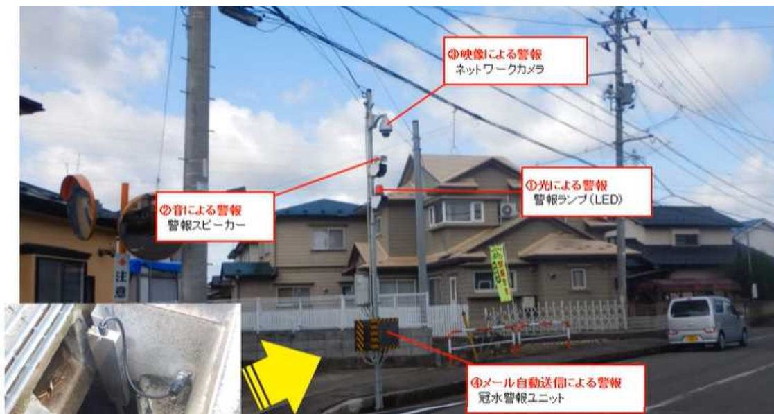
浸水センサー 雨水管に接続する集水槽内部の水位の上昇を検知
