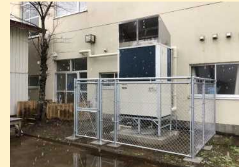
空調設備の基礎嵩上げ
