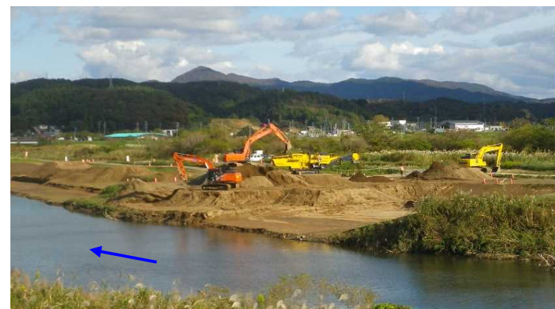
▲河道掘削状況
