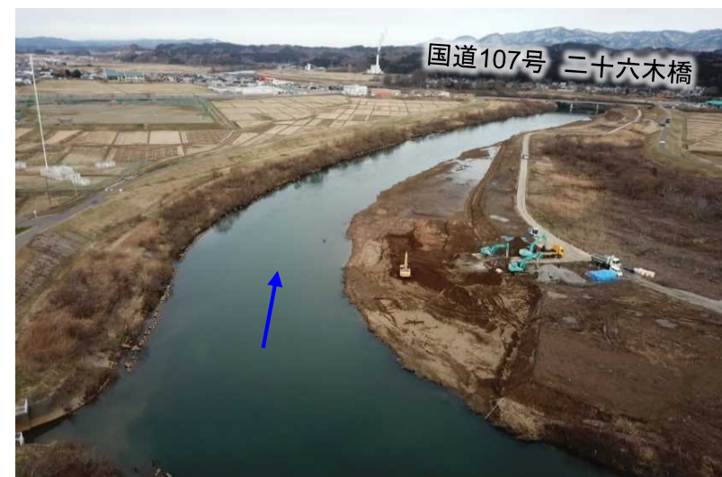
▲河道掘削状況
