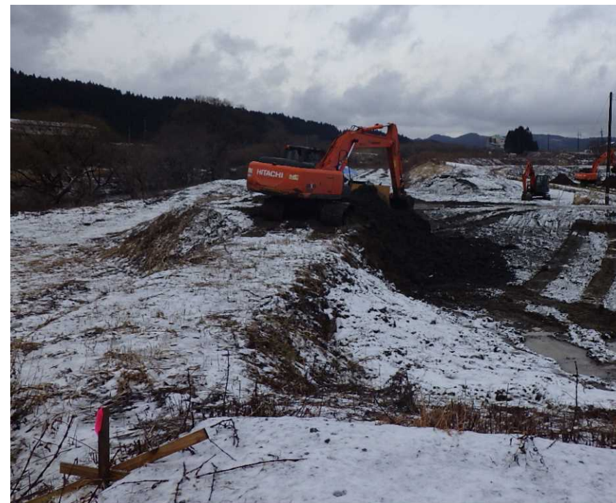
▲河道掘削状況
