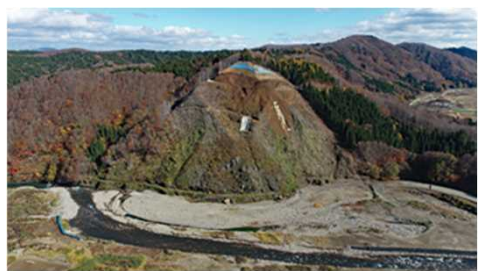
右岸上部掘削工事 掘削状況
