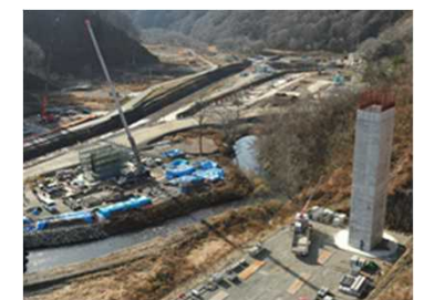
付替市道4号橋下部工工事 施工状況
