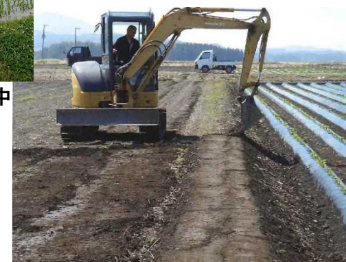
バックホウによる畦畔の嵩上げ
