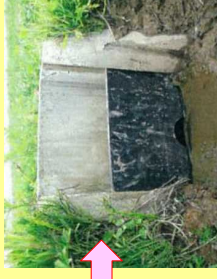
水戸板設置状況
