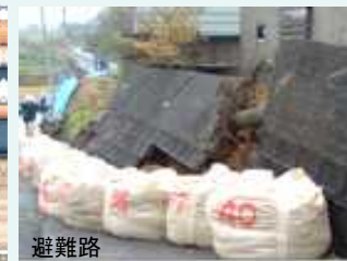
擁壁の防災対策
