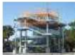
津波避難タワー
