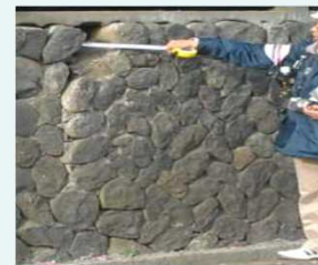
擁壁の危険度調査
