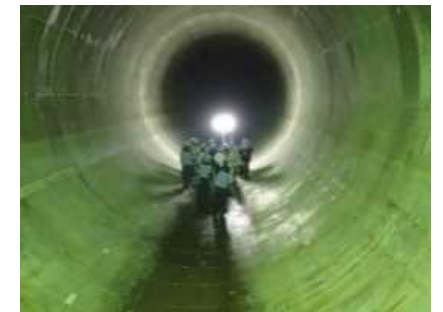
雨水貯留管の整備
