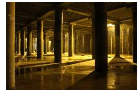
貯留施設の整備
