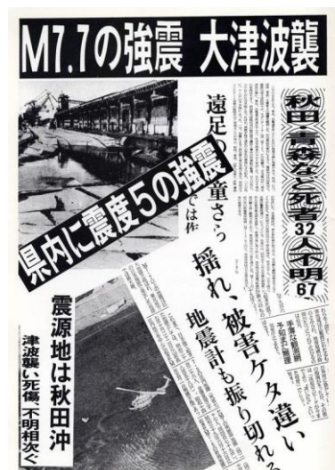
図 3-5 日本海中部地震 (S58.5) についての報道状況
