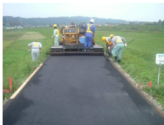
堤防天端の舗装
