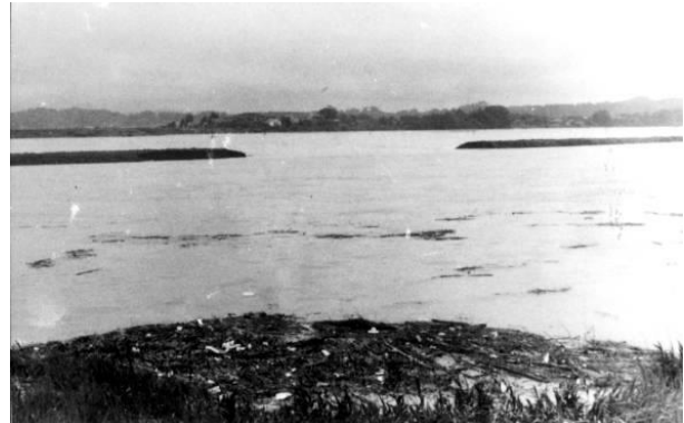
堤防破堤箇所(宮内地区)を右岸より望む
