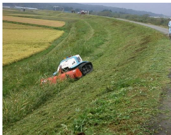
堤防法面の除草
