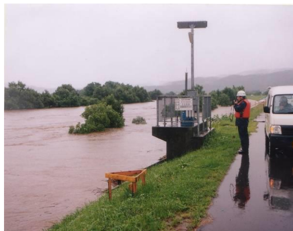
出水時の巡視
