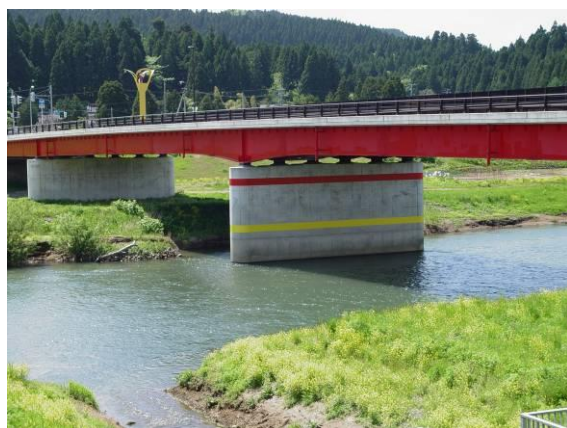
滝沢橋（警戒水位、危険水位をわかりやすく示している）
