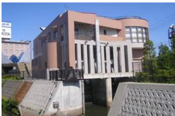
大沢川排水機場
