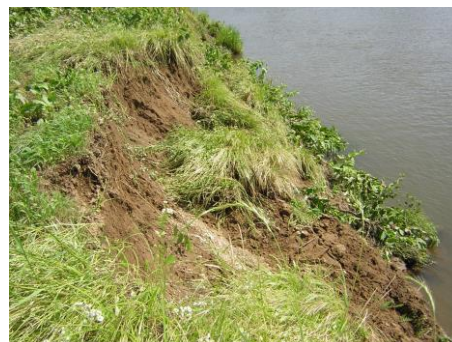
河岸崩壊の状況
