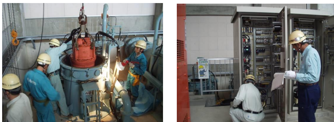
排水機場内の点検・調査状況
