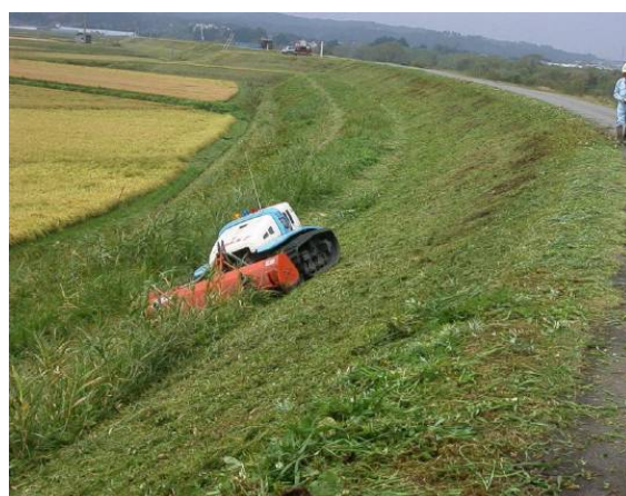
堤防法面の除草
