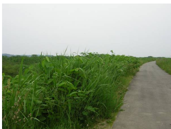
堤防法面の雑草が繁茂している状況
