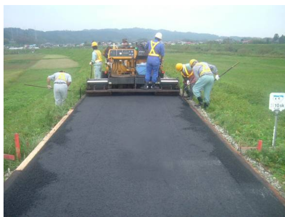
堤防天端の舗装
