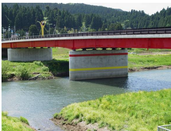
滝沢橋（警戒水位、危険水位をわかりやすく示している）
