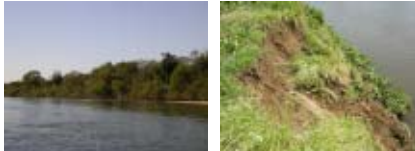
樹木の繁茂状況 河岸の崩壊状況
