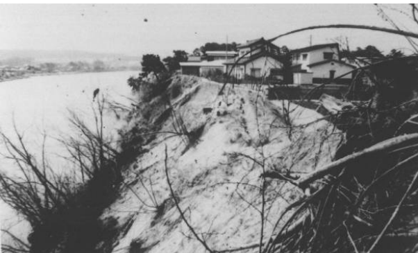
旧本荘市(尾花沢地区)の崩落した河岸
