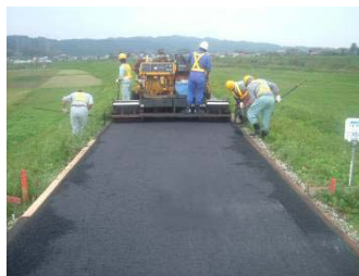
堤防天端の舗装
