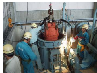
排水機場内の点検・調査
