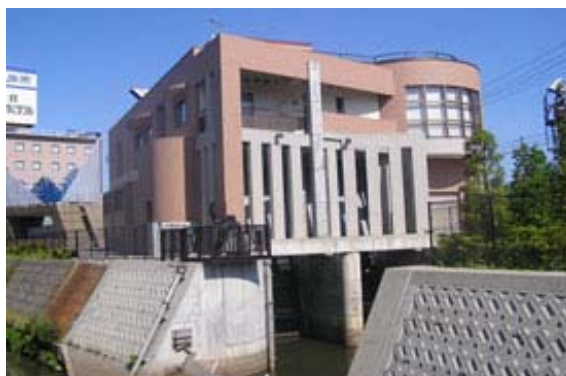
大沢川排水機場
