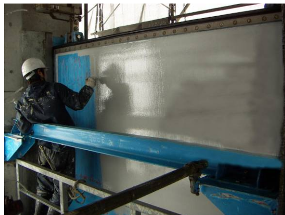
ゲートの補修
