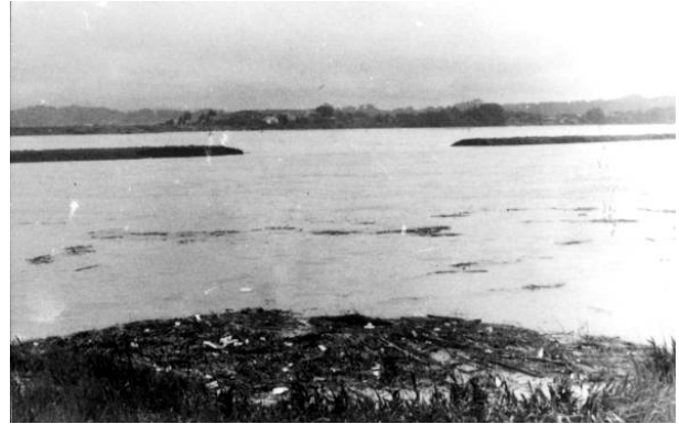
堤防破堤箇所(宮内地区)を右岸より望む
