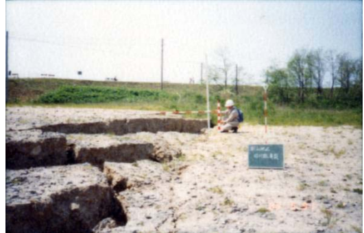
河川管理施設の点検例 (日本海中部地震時の雄物川の事例)
