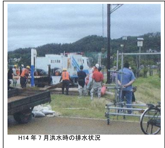
子吉川に配備されている排水ポンプ車
