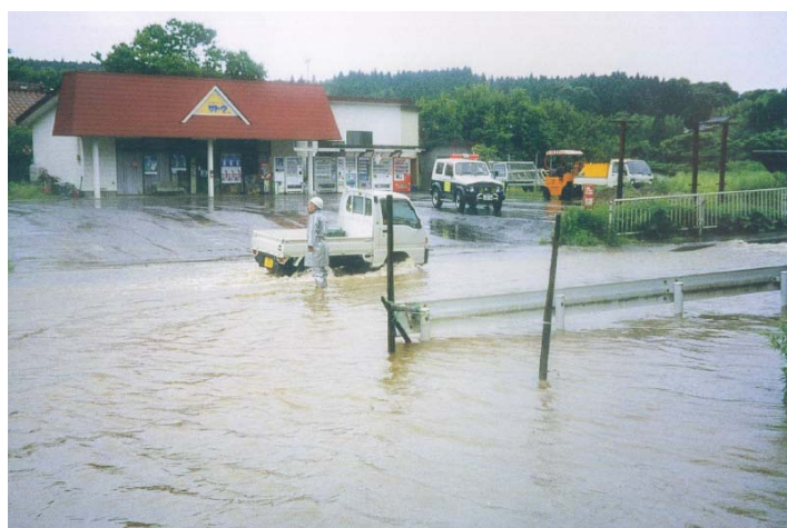
内水による国道の冠水状況 (H14 年 7 月洪水、国道 108 号鮎川橋付近)
