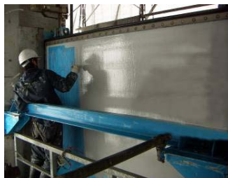
ゲートの補修
