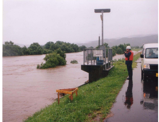
出水時の巡視状況
