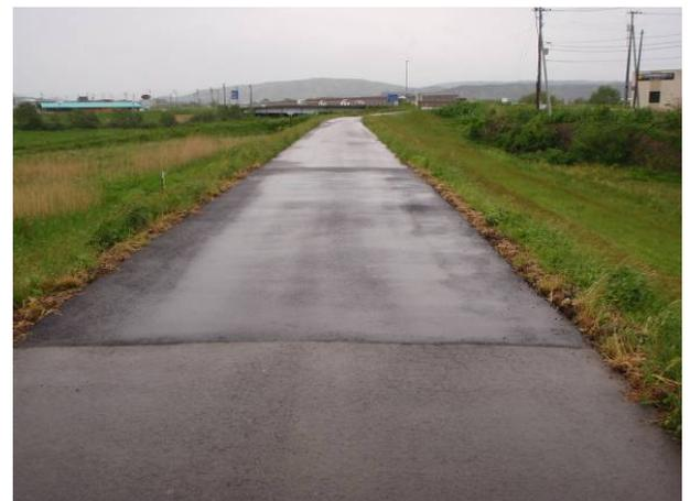
堤防の上面舗装補修後の状況
