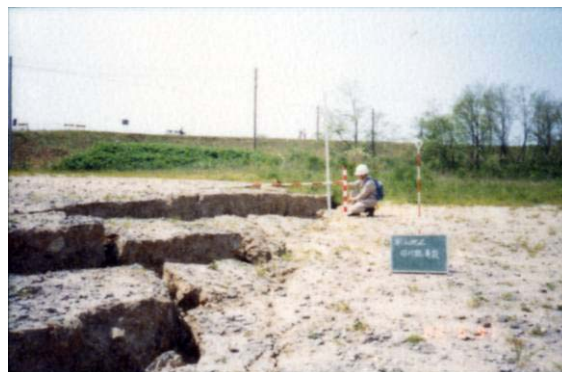
図 5-24 河川管理施設の点検例（日本海中部地震時の雄物川の事例）
