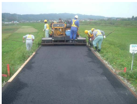
堤防天端の舗装
