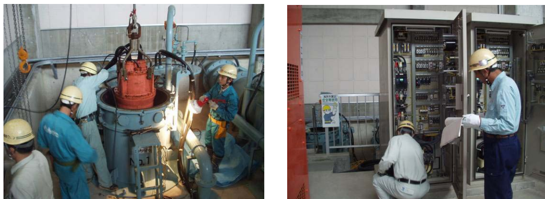
排水機場内の点検・調査状況
