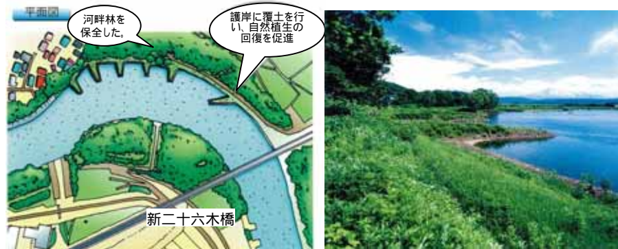
(施工後2年3ヶ月経過)
