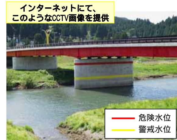
危険水位・警戒水位をわかりやすく示した橋脚
