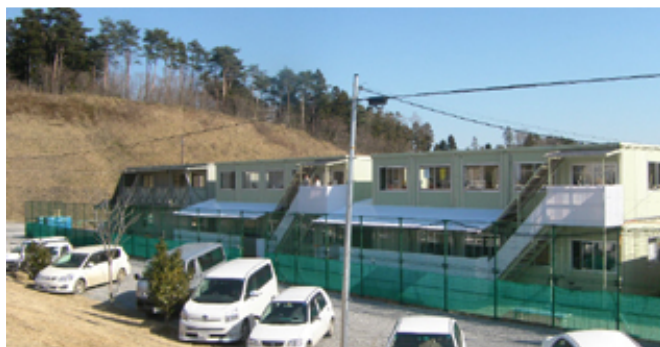
▲ 仮設ハウス（南三陸町仮庁舎）
