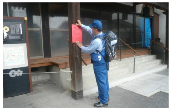
▲ 熊本市内での建築物危険度判定（建築物判定班）
