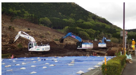
▲ 遠隔操縦式バックホウによる土砂撤去作業
