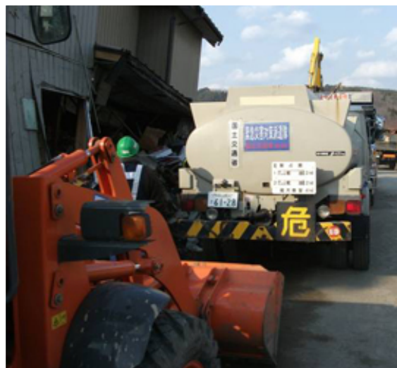
▲ 燃料提供（ブルドーザに給油中）
