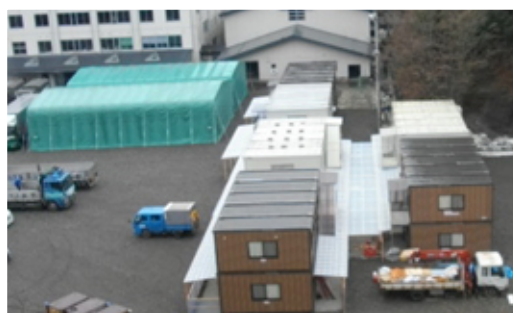
▲ 仮設ハウス（大槌町仮庁舎）
