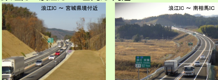
(写真: 東日本高速道路(株)提供)
