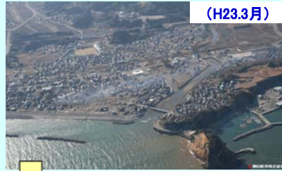
<海岸堤防の進捗と 久之浜地区防災緑地施工状況> (H23.3月)
