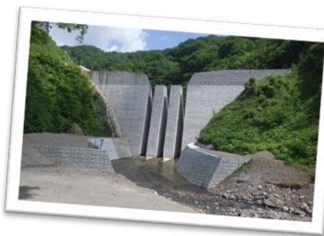
▲シガラ沢砂防堰堤
