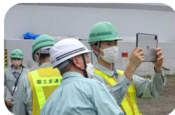
AR技術を用いた現地確認（道路）
