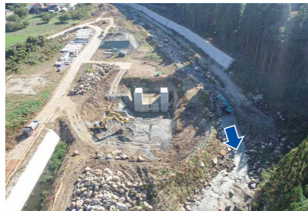
▲施工中(内川遊砂地) 令和6年11月
