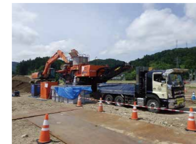
INSEM材の攪拌混合・積込状況
