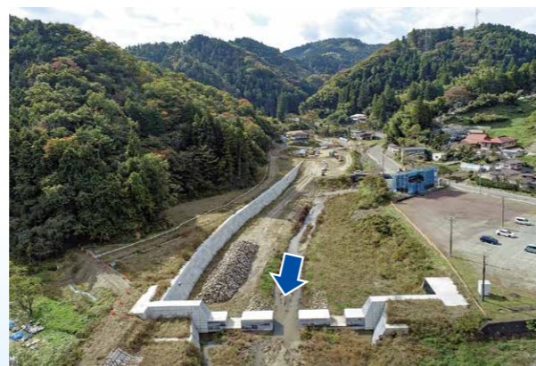
▲施工中(新川遊砂地) 令和6年11月
