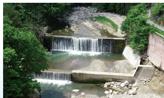
▲着手前(不動尊砂防堰堤)
