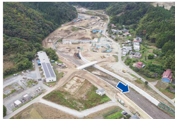
▲施工中(五福谷川遊砂地) 令和6年11月
