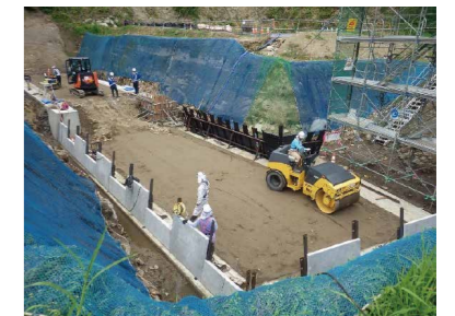
転圧状況 (薄平沢砂防堰堤)
