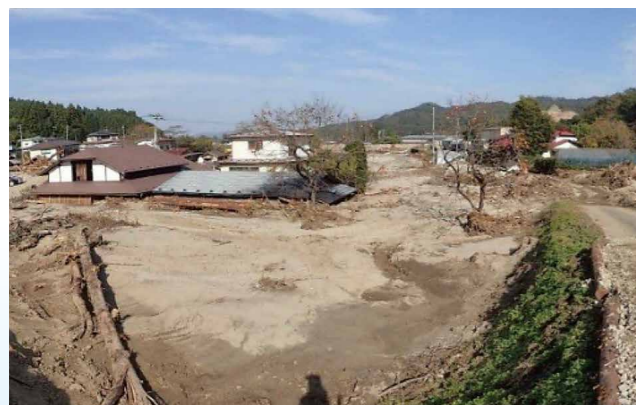
土砂・洪水氾濫による被害状況(五福谷川)
