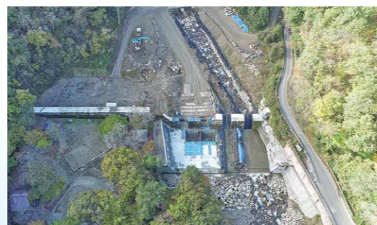
▲施工中(不動尊砂防堰堤) 令和6年11月
