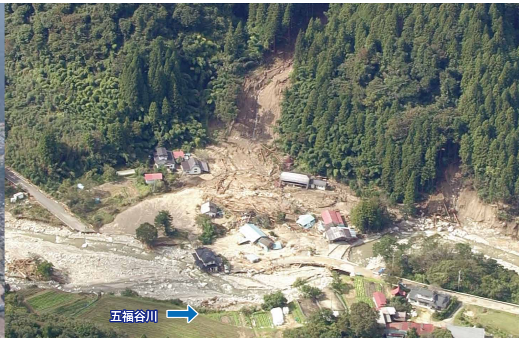
土石流による被害状況(五福谷川)
