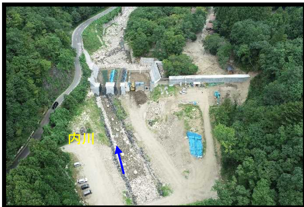
不動尊砂防堰堤上流(空撮)
