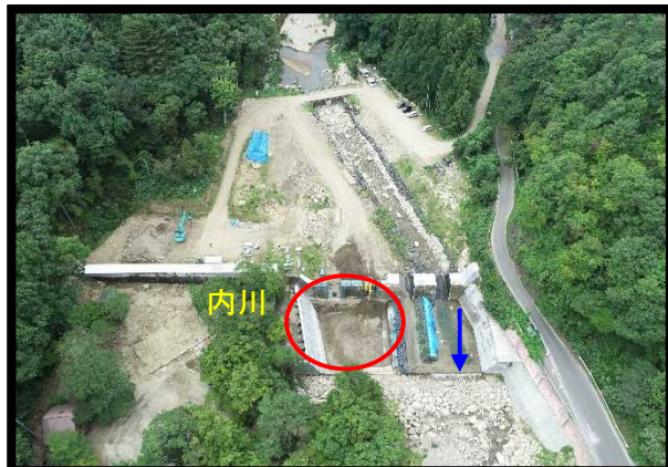
不動尊砂防堰堤下流(空撮)
