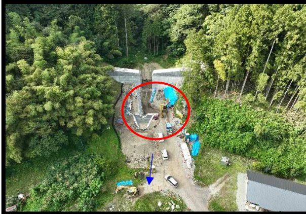
大畑沢砂防堰堤下流(空撮)
