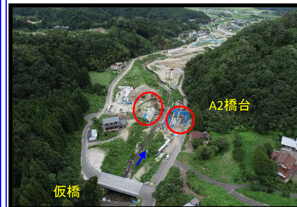
仮橋、橋台の写真(空撮)
