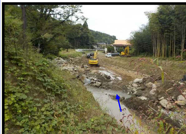
新川遊砂地上流(空撮)
