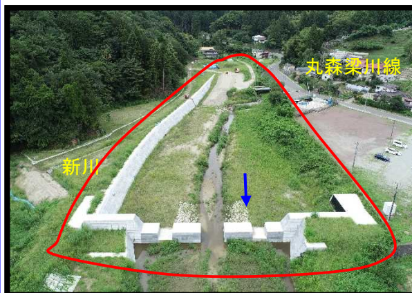
新川遊砂地 下流(空撮)
