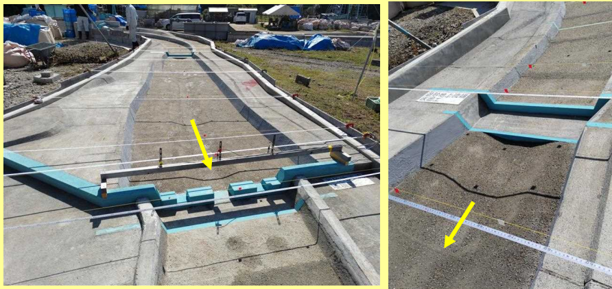
新川遊砂地(低水路:幅5m高さ1m)
