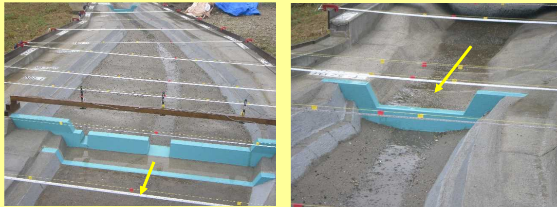
内川遊砂地(低水路:幅9m、高さ1.5m)
