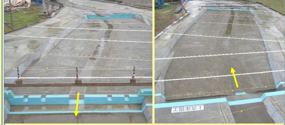
五福谷川遊砂地(低水路:幅8m高さ1.5m)
