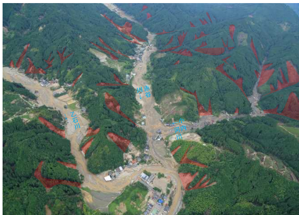
H29年7月九州北部豪雨による 筑後川水系 赤谷川の被災事例
