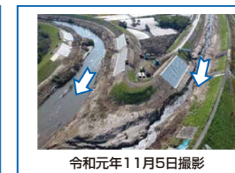
応急復旧完了後の状況
