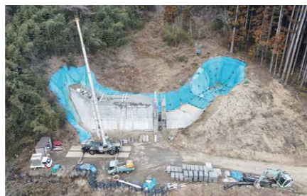
▲新設工事（下北山砂防堰堤）
