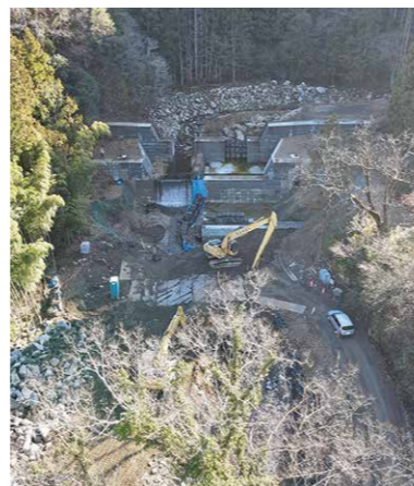
▲スリット化工事（土ヶ森砂防堰堤）
