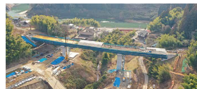
施工状況③（仮）第2号橋
