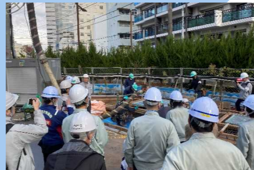
仙台合同庁舎A棟 (耐震改修)
