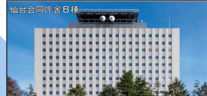
仙台合同庁舎B棟
