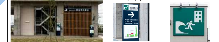
屋外避難階段 避難階段への案内サイン 津波避難ビルサイン
