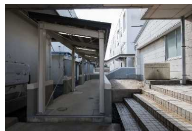
【渡り廊下（警察学校側）】
