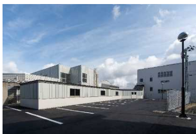
【渡り廊下（機動隊側）】
