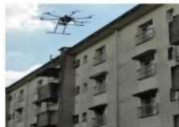
【ドローンによる外壁調査(イメージ)】
