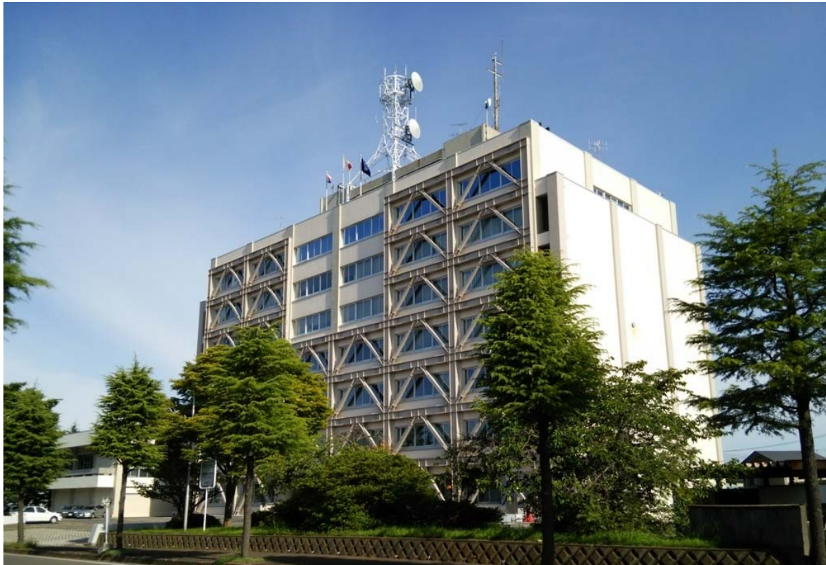
【耐震改修工事が完了した塩釜港湾合同庁舎】
