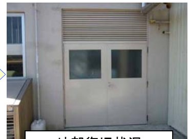
外部復旧状況
