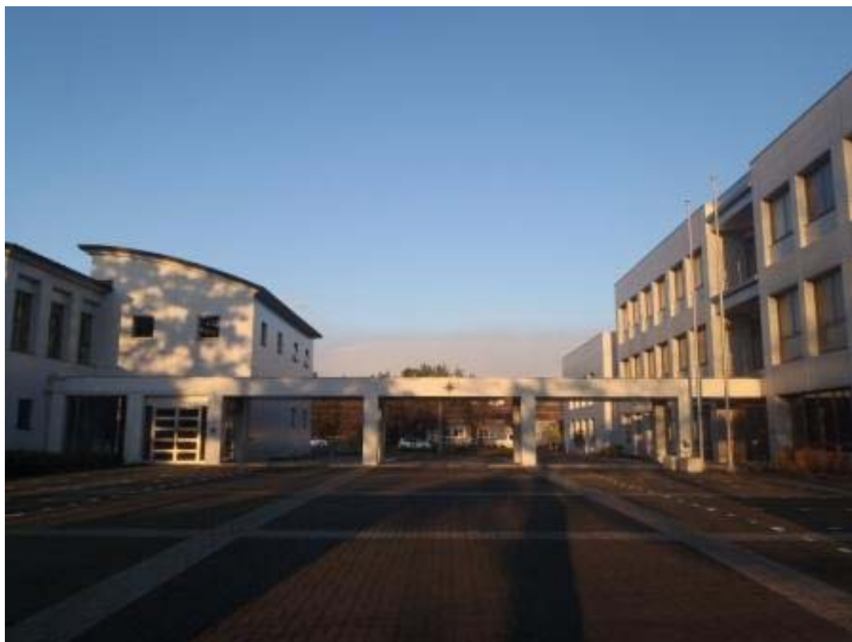
東日本大震災で津波浸水被害を受け、復旧工事を行った海上保安学校宮城分校
