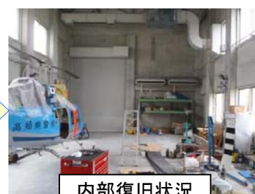
内部復旧状況
