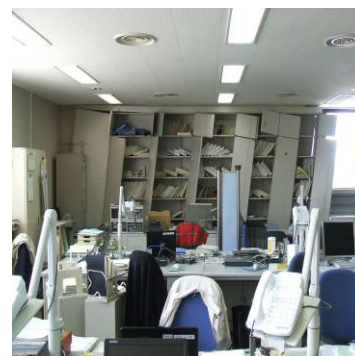
収納物の移動により家具が変形
