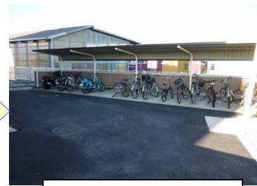
自転車置場復旧状況
